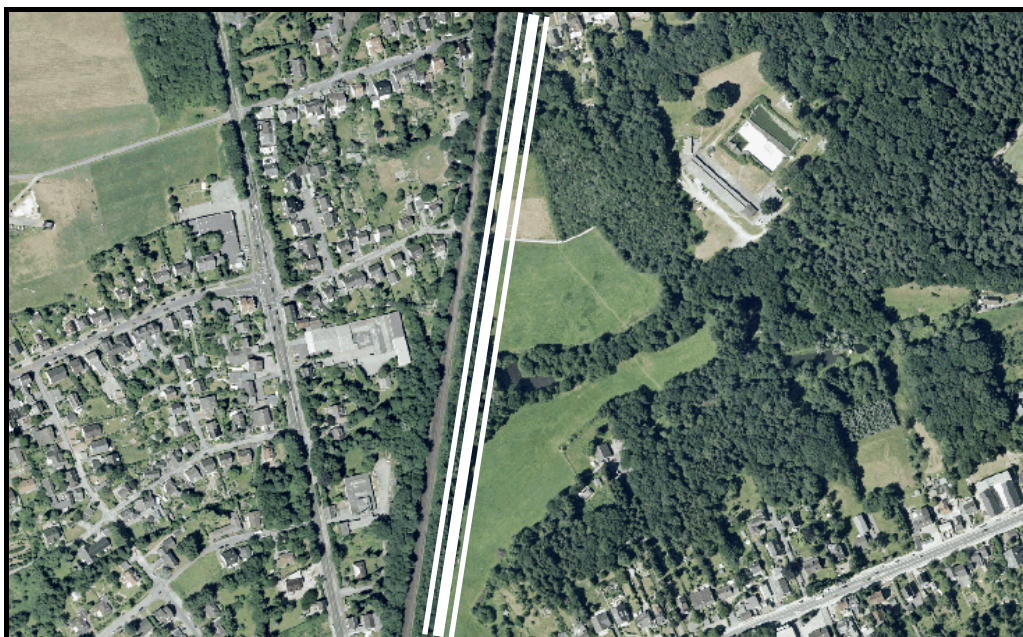
Luftbild 1: Von der Straßenneubauplanung betroffenen Wald-, Hecken-, Wiesen- und Kleingewässerkomplex am Erikaweg. Potenzieller Trassenverlauf markiert.
